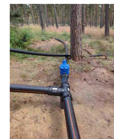
Abbildung 3: Verteilnetz für die Verrieselung
