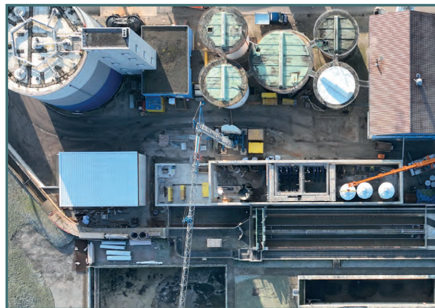
Die Umbauarbeiten an der Schlammagerhalle sind im vollen Gange
