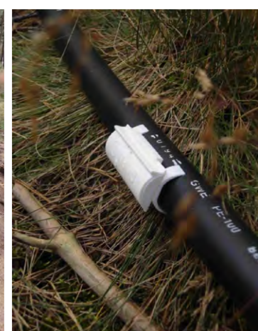
Abbildung 4: Tropfer in der Verrieselungsleitung
