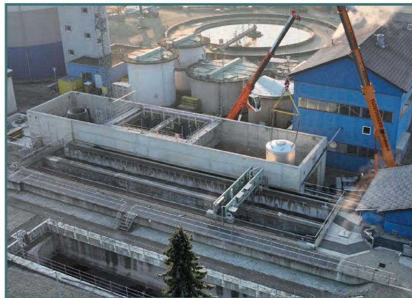
Der erste Edelstahlbehälter wurde in die Halle eingehoben
