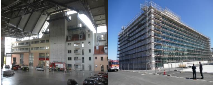
Abb. 1 links: Blick in die Ausbildungshalle des Instituts der Feuerwehr Nordrhein-Westfalen, rechts: Blick auf den eingerüsteten Neubau der Übungshalle der staatlichen Feuerweherschule Würzburg.
