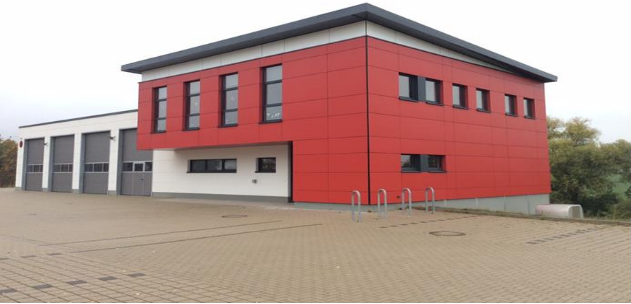
Abbildung 1: Neubau Feuerwehr Diekholzen mit Hebel Systemwandelementen
