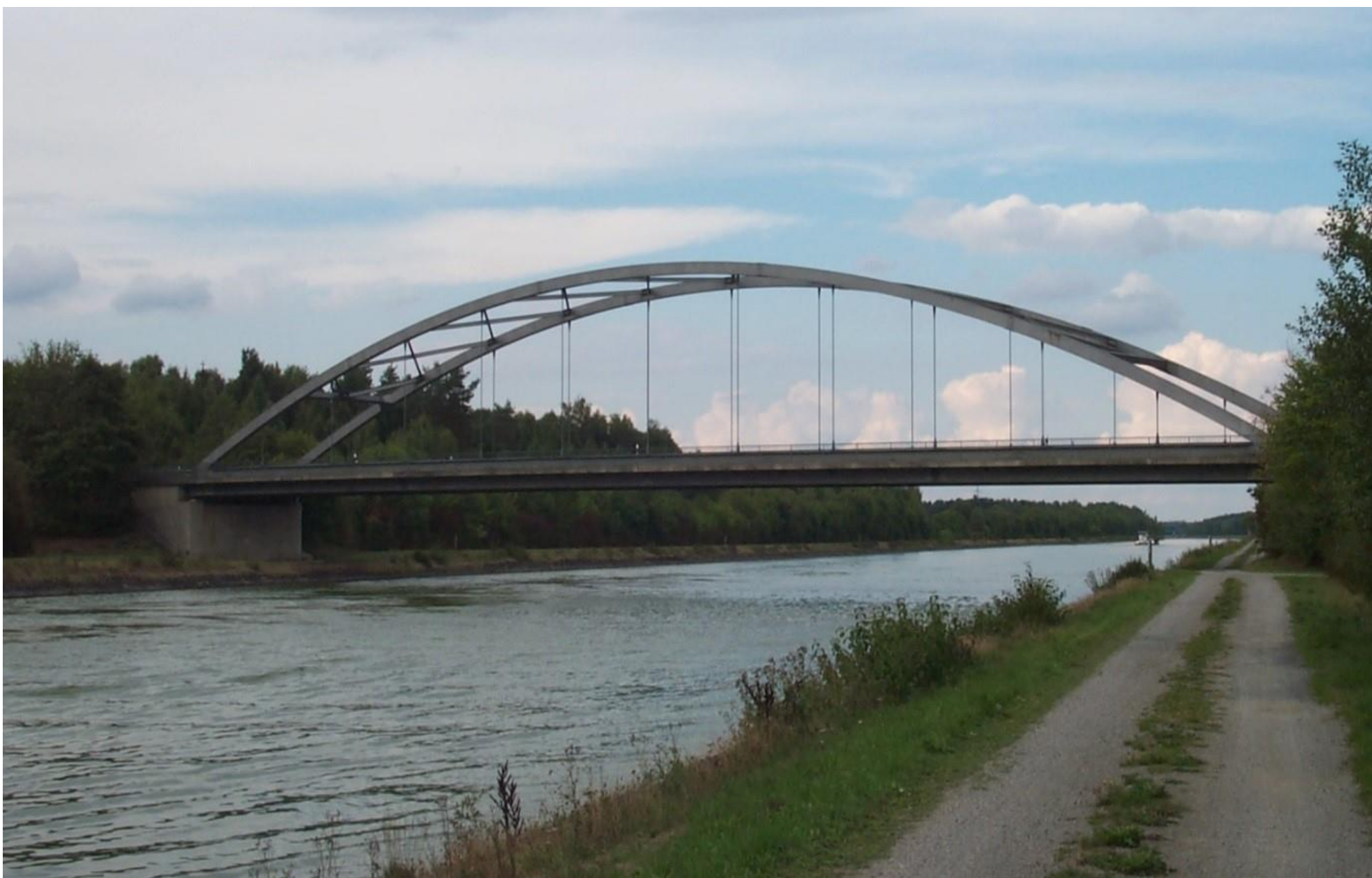
Abb.1: Südansicht der Straßenbrücke Nr. 518
