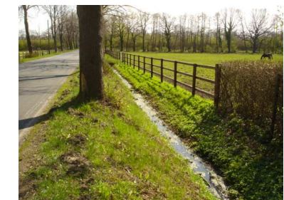
Abbildung: Entwässerungsgraben K324
